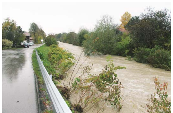
Der Wasserstand in der Rohrdorfer Achen stieg in Rohrdorf gefährlich hoch an. Probleme gab es durch das Hochwasser neben den flussnahen Siedlungsbereichen vor allem in der Markus- und der Hubertusstraße
