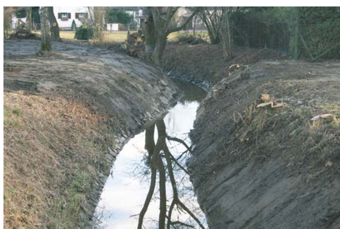
Links noch der alte Zustand des Bahngrabens mit Brücke, rechts der Bahngraben nach dem Brückenabbruch
