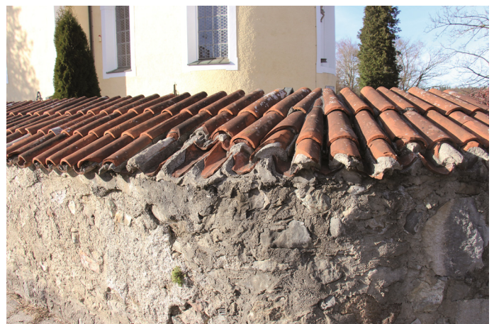
die schon sanierte Friedhofsmauer
