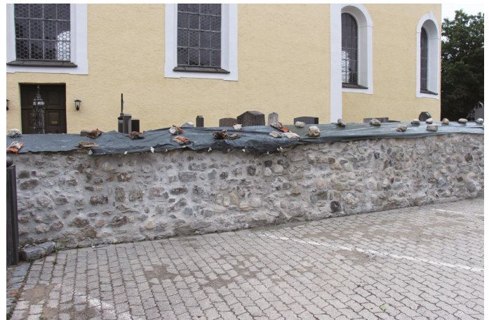
der Zustand vor der Sanierung
