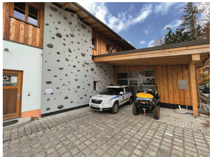
Einsatzleitfahrzeug und Geländefahrzeug vor dem neuen Anbau und der Kletterwand
