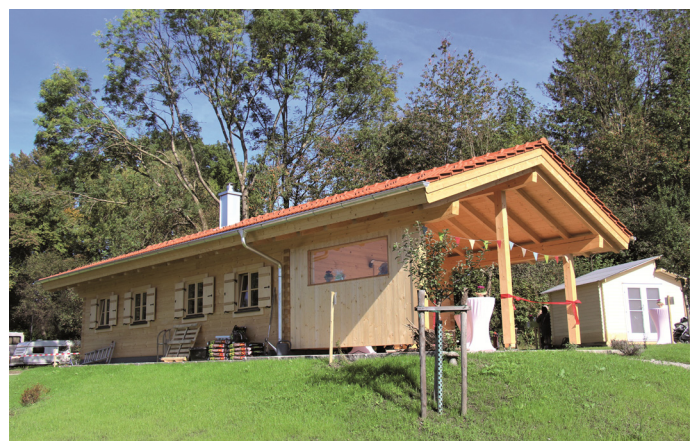
Die Holz-Schutzhütte des Naturkindergartens von außen
