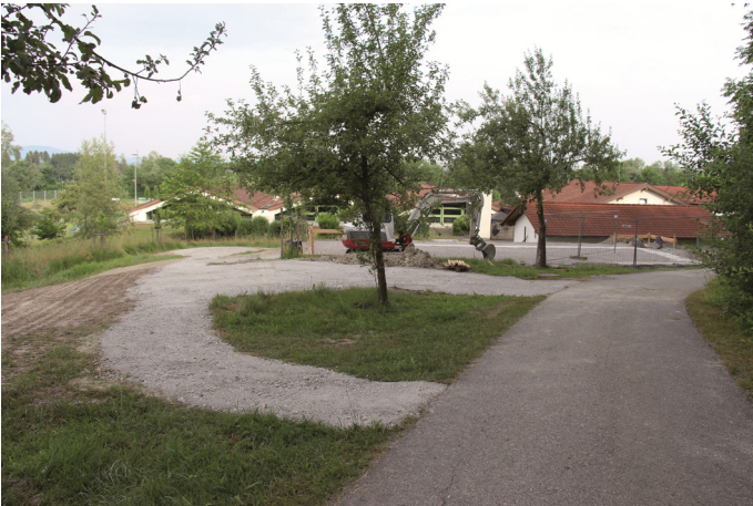
Die Fundament- und Geländemodellierungsarbeiten für den neuen Naturkindergarten sind bereits im vollen Gang
